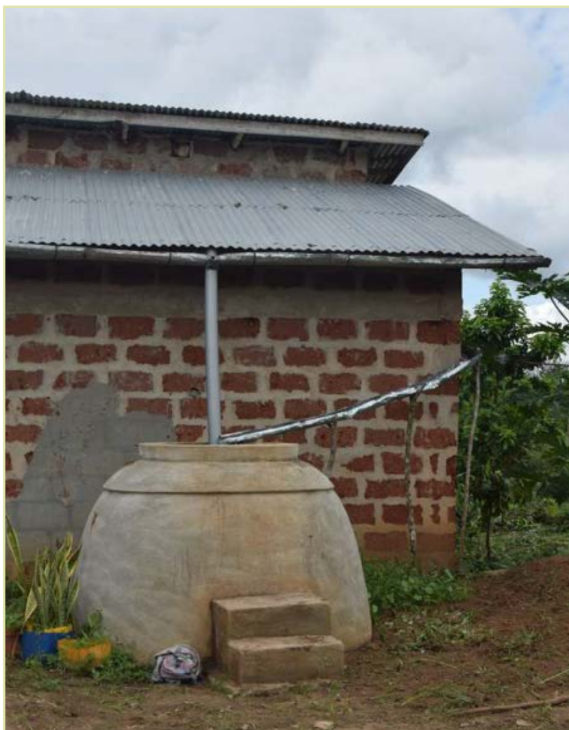
Système de récupération de l'eau de pluie au domicile d'une fermière modèle de Kpakpaza, au Bénin, en vue d'une utilisation pour les cultures maraichères
